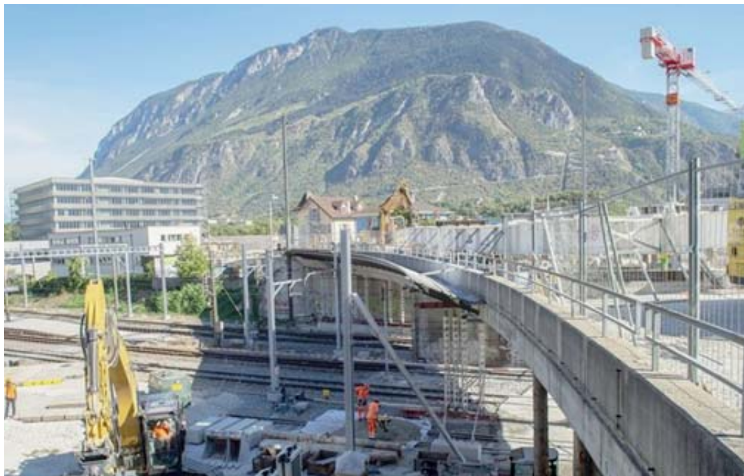
Le pont Beaulieu avait été démolé en 2018 pour permettre le passage des trains à deux étages. BITTEL/A
