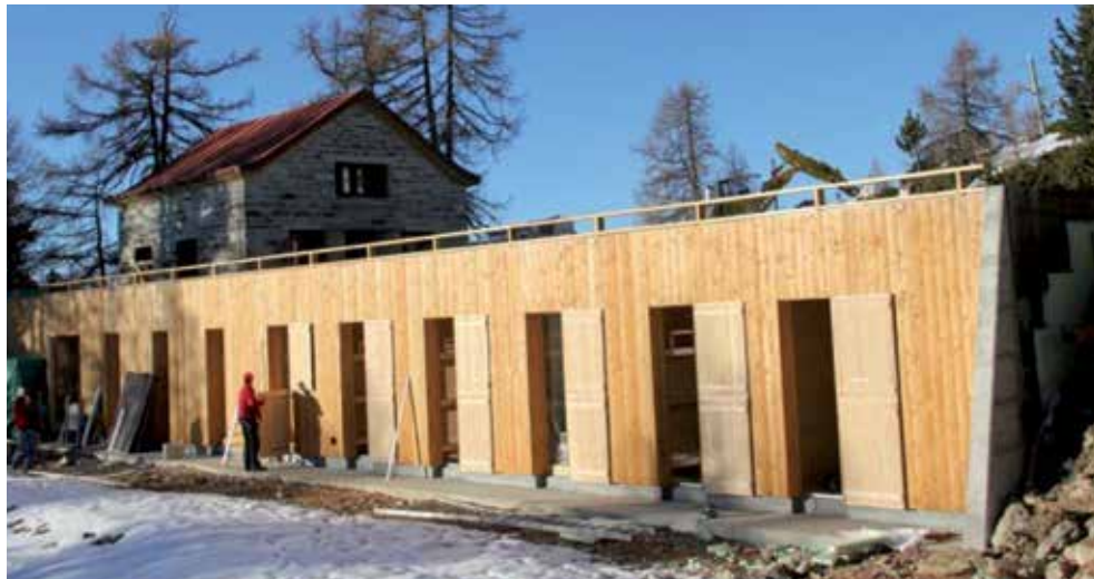
Les travaux de rénovation ont abouti à la construction d'une annexe pouvant accueillir jusqu'à 50 personnes, tout en conservant l'aspect original et authentique de la cabane Illhorn. LDD
