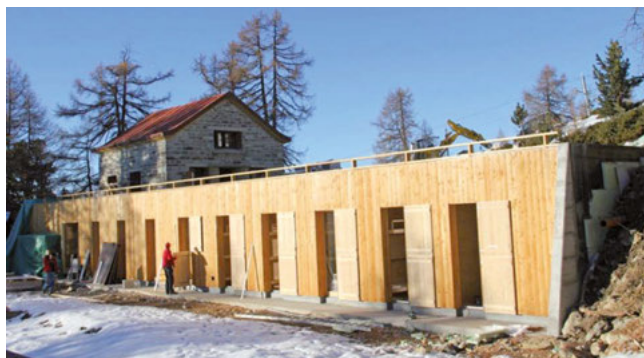
Alors que les logements en cabane d'altitude enregistrent en 2012 près de 310'000 nuitées en Valais, leurs rénovations vont bon train durant ces dernières années à travers le canton. En effet, n'ayant, pour beaucoup, subi que de menues transformations depuis leur construction, les cabanes souhaitent s'ajuster et répondre à la demande actuelle (ici la cabane Illhorn à Chandolin). Le soutien sous forme de prêts sans intérêts est bienvenu pour réaliser ces travaux souvent portés par des associations. DR
