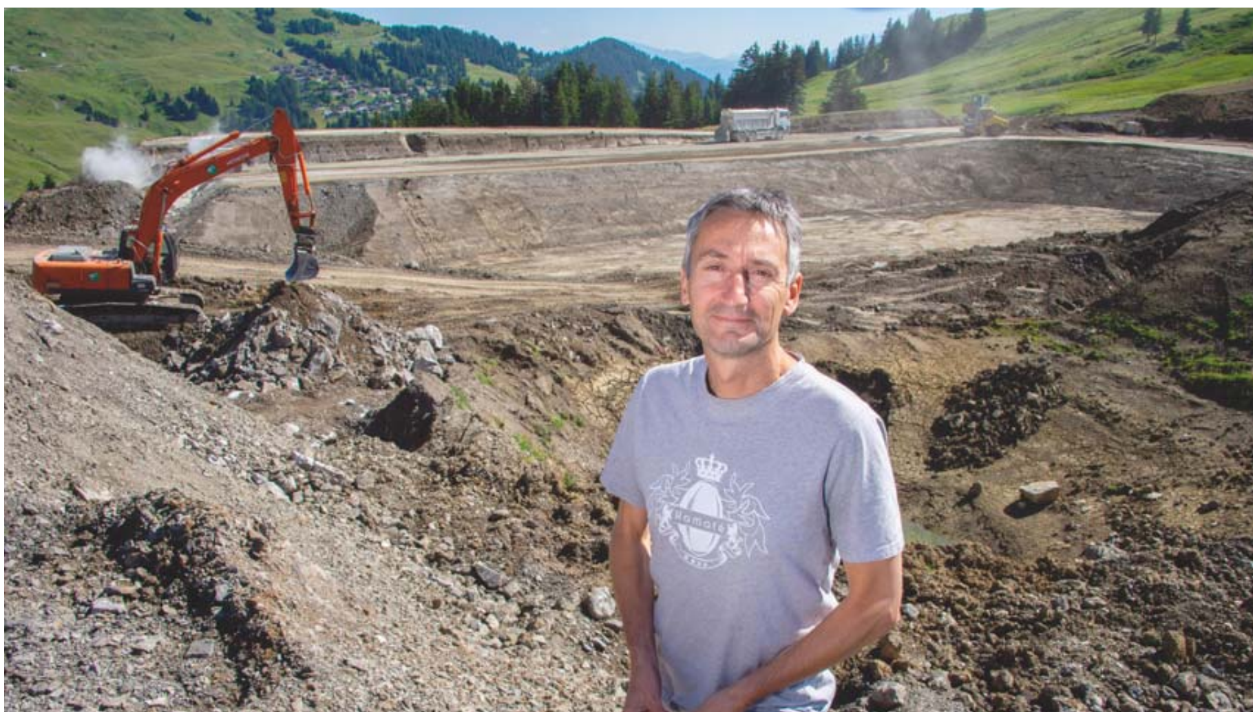
Le directeur de TéléChampéry-Crosets SA, Pascal Bergero pose devant la future retenue en construction au Chaudron. SACHA BITTEL
