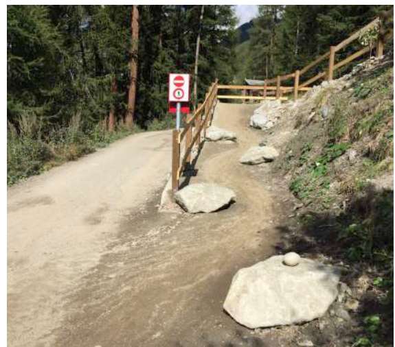
Chicane sur piste VTT avant jonction avec un chemin forestier (source: BikePlan AG > Sunnegga-Trail)
