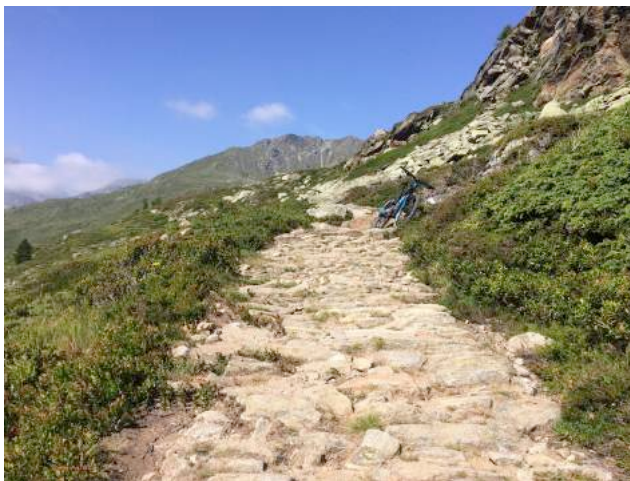
Enrochement traditionnel centenaire sur des tronçons raides proche du Col du Simplon (source: BikePlan AG)
