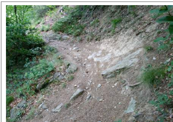
Talus amont roulé dans un virage pentu, partiellement érodé (source: BikePlan AG)
