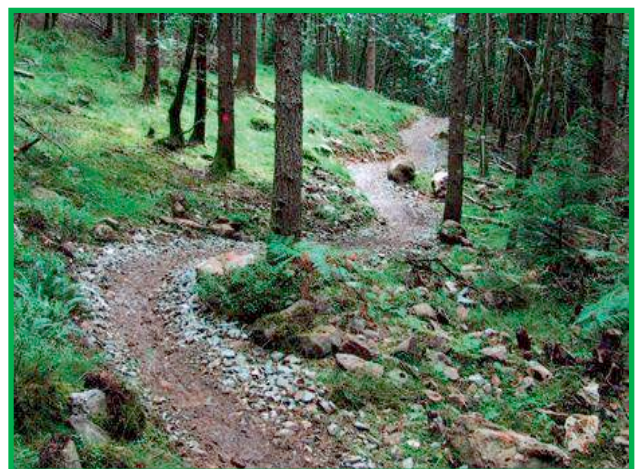
Exemple de chemin avec plusieurs inversions de pente adaptées à la topographie (source: IMBA)
