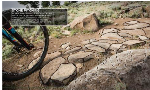
Visualisation du Stone Pitching à la surface et dans le sol (source: IMBA. Guidelines for a Quality Trail Experience. mountain bike trail guideline, 2017)
