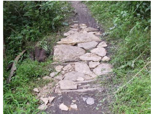
Renforcement en pierres pour la traversée d'une zone humide ou d'un ruisseau (source: https://pinchflat.files.wordpress.com/2008/08/boyce005.jpg )
