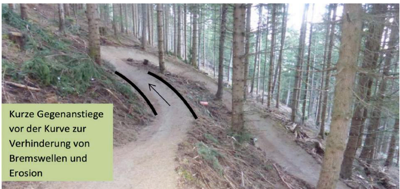
Recommandation : courte contre-pente avant les virages pour éviter les vagues dues aux freinages et l'érosion (source : Tiroler MTB-Modell 2.0)
