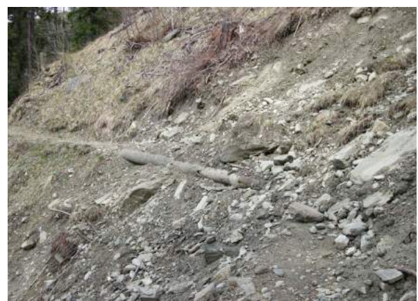
Glissement de terrain à l'amont du chemin avec ensevelissement partiel du chemin, favorisé par l'eau de fonte. (source: www.herzhaft-wandern.ch, Cornelia Zürrer)
