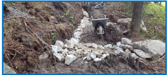
Construction d'un drain au Moos-Trail, Zermatt (photo: BikePlan AG)
