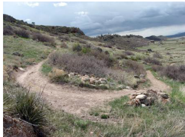
Virage à 180° réalisé à la main (source: www.gregridestrails.com)
