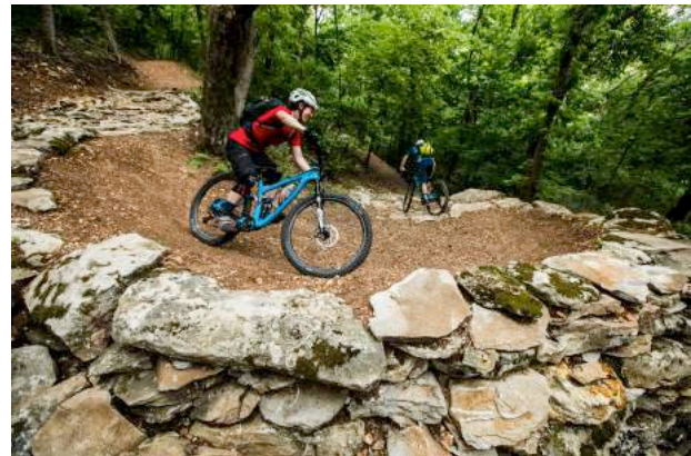
Virage relevé avec construction en pierres visible, Bentonville USA (source: www.outerbike.com/bentonville-2018/)
